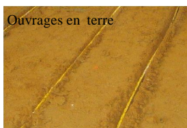
Ouvrages en terre Déformations, détection de fuites, affaissements, .../...
